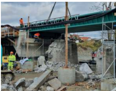
Errichten einer Eisenbahnbrücke
