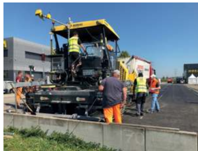
Autonomer Probereinbau mit voll instrumentierten Fertiger
