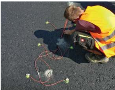
Einbau von Beschleunigungssensoren
