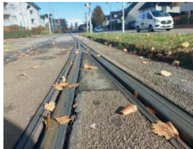
Straßenbahn-Fahrbahn mit Rillenschiene
