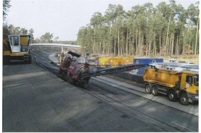
Bild 6: Um in der geneigten Bahn fräsen zu können, wurde die Maschine bei Querneigungen über 9° von einem Windenwagen gehalten
