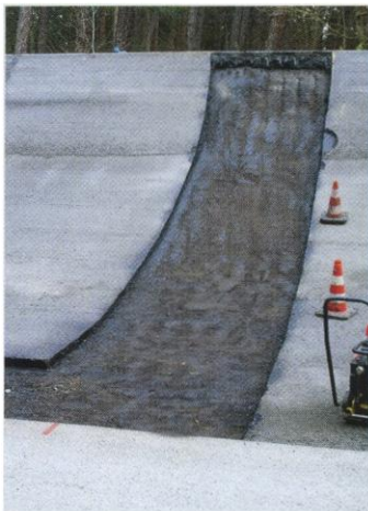
Bild 7: Die Ausbesserungsarbeiten an der Tragschicht erfolgten manuell
