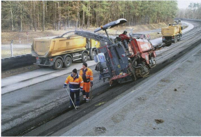
Bild 5: Die Kaltfräse arbeitete horizontal und verlad das anfallende Fräsgut über das Ladeband direkt auf die Lkws
