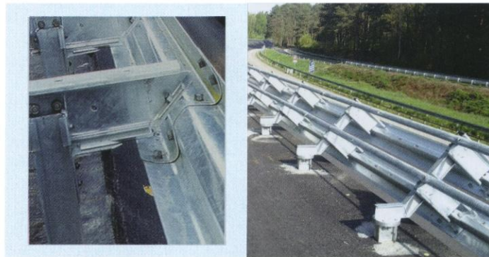
Bild 12: Die Stahlenschutzplanken an der Oberkante der Steilkurve: vorher als einfache Leitplanke (links), nun in doppelter Ausführung mit EDSP
