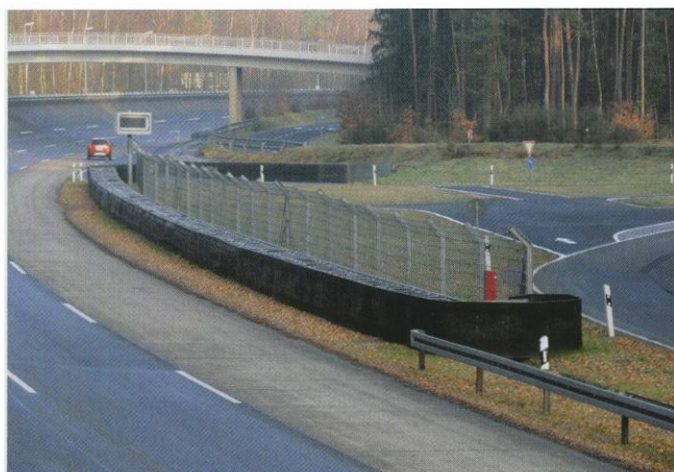
Bild 13: Reifenstapel und Fangzäune sorgen für die Sicherheit der Fahrer und des Personals, das sich während der Tests entlang der Strecke aufhält
