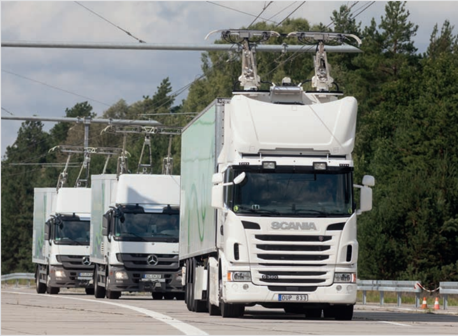
Bild 3: Oberleitungs-Lkw und angepasste Fahrleitungsinfrastruktur im System eHighway (Foto: www.siemens.com/presse)
