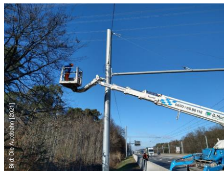
Bild 2: Gehölzpflege auf der ELISA-eHighway-Teststrecke
