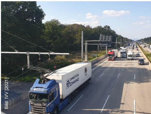
Bild 1: ELISA-eHighway-Teststrecke BAB 5 zwischen Frankfurt am Main und Darmstadt
