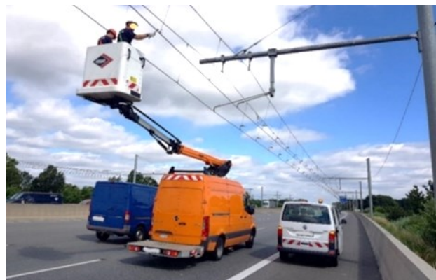
Abbildung 8: Inspektion der Fahrleitungsanlage aus einem Hubsteiger (Siemens)
