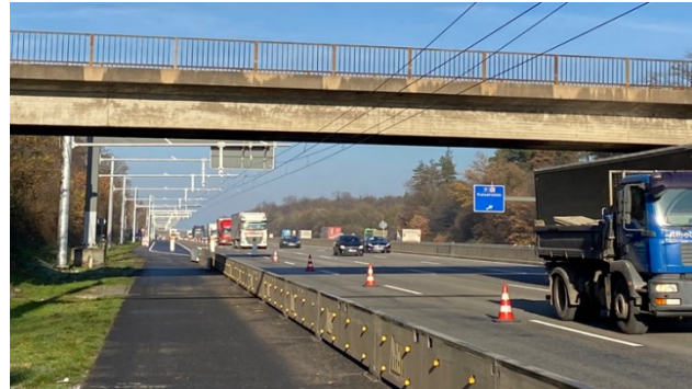
Abbildung 6: Transportable Schutzeinrichtung zwischen Seitenstreifen und erstem Fahrstreifen (Siemens)
