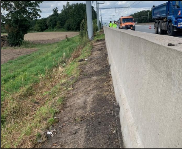
Abbildung 3: Regulierung und Profilierung des Banketts mit einer nach außen gerichteten Querneigung (Autobahn GmbH, 2024)
