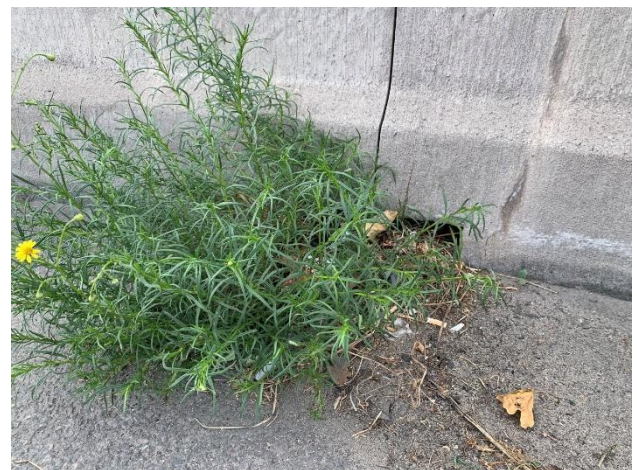
Abbildung 2: Durch Pflanzen und Sedimente blockierte Öffnung am Fuße einer Schutzwand aus Ortbeton (Autobahn GmbH, 2024)
