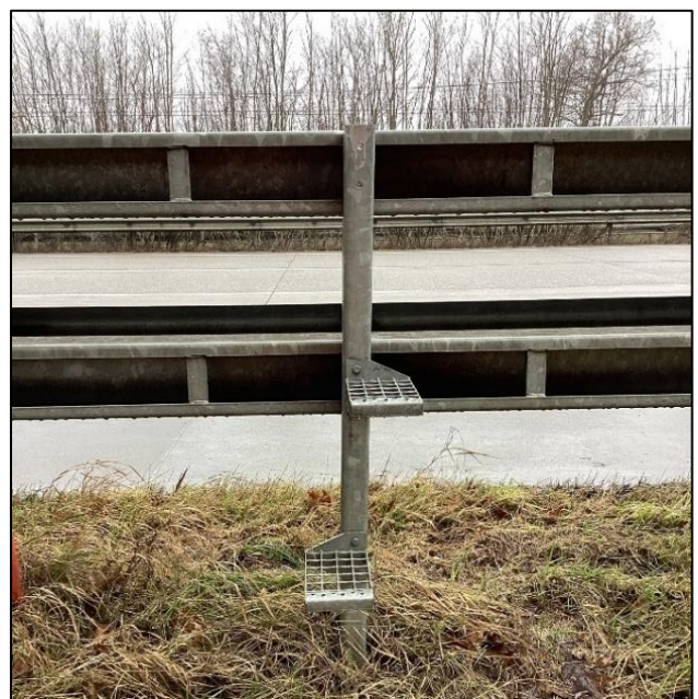
Abbildung 4: Übersteighilfe fest an Schutzplanke montiert (Autobahn GmbH, 2025)
