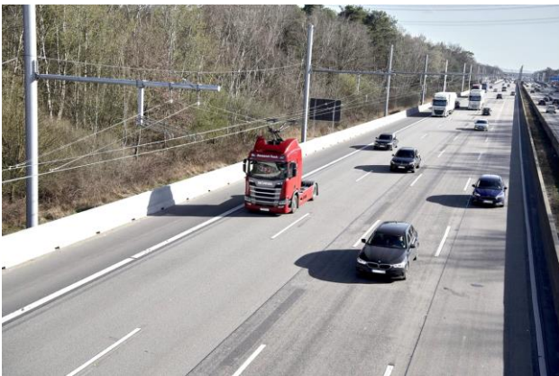
Abbildung 9: Testfahrten auf der ELISA-Versuchsanlage
