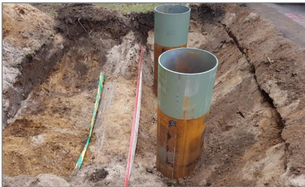
Abbildung 7: Unterirdisch verlaufende Bestandstrassen (Siemens)
