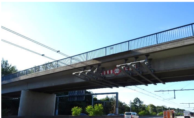
Abbildung 5: Fahrdrachtabsenkung Brückenbauwerk (Siemens)
