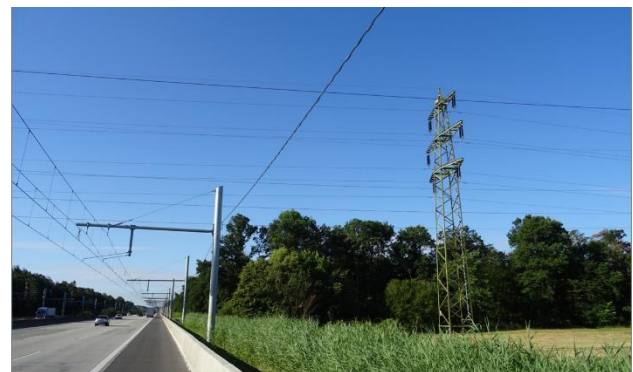
Abbildung 6: Fahrdrachtabsenkung Brückenbauwerk (Siemens)
