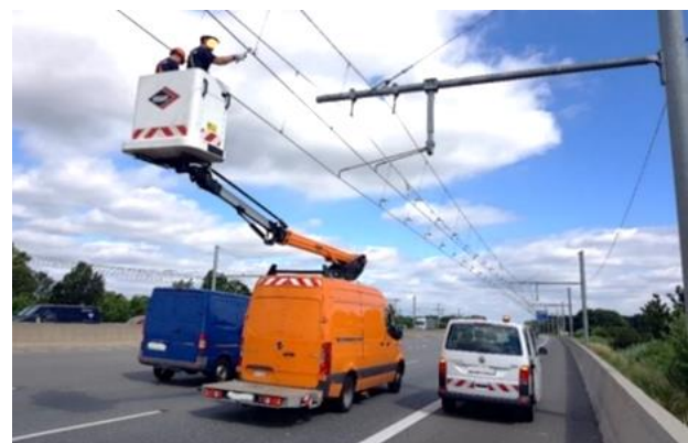
Abbildung 10: Inspektion der Fahrleitungsanlage aus einem Hubsteiger
