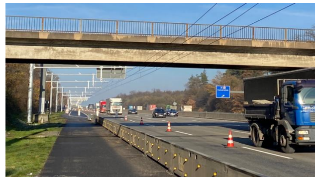
Abbildung 8: Transportable Schutzeinrichtung zwischen Seitenstreifen und ersten Fahrstreifen (Siemens)
