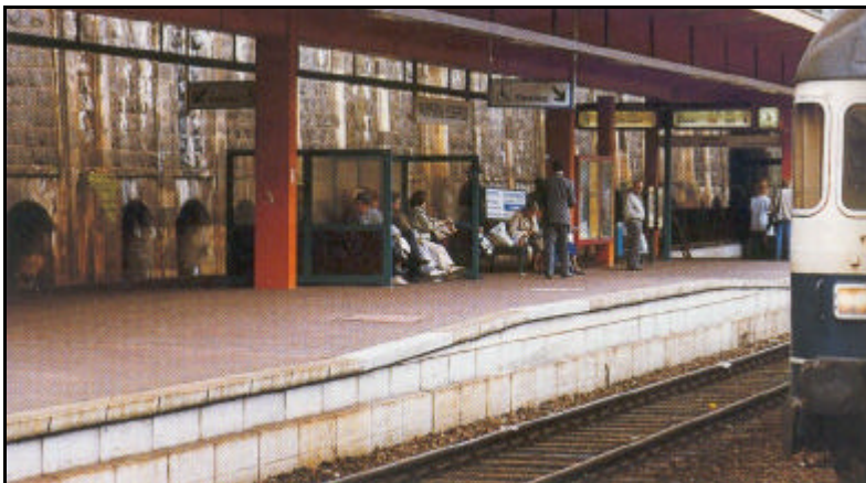
Bild 8: Teilerhöhung eines Bahnsteigs [57]
