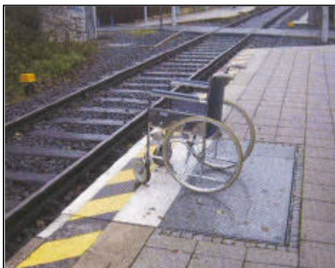
Bild 9: Hublift an einem Bahnsteig [57]
