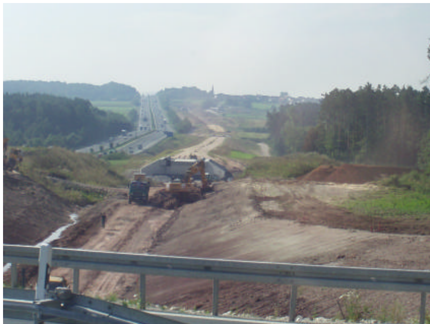
Bild 4: Die Hochgeschwindigkeitsstrecke Nürnberg – Ingolstadt im Bau
